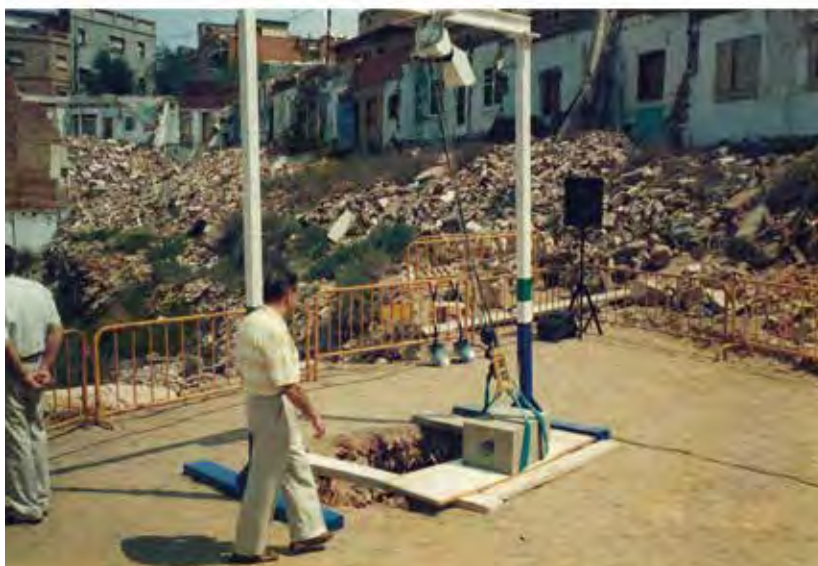
22 de juliol de 1994. Acte de col·locació de la primera pedra del futur Centre d'Atenció Primària Santa Rosa a l'antiga illa d'habitatges del carrer d'Elcano. Arxiu privat Manel Tomàs.
