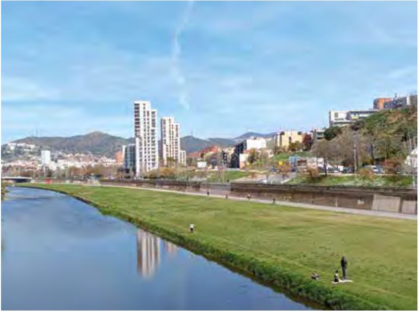
Una imatge actual on es pot apreciar la remodelació total del Front Fluvial del Besòs, així com la construcció dels dos alts gratacels a l'esquena del Raval. Fotografia de l'autor.
