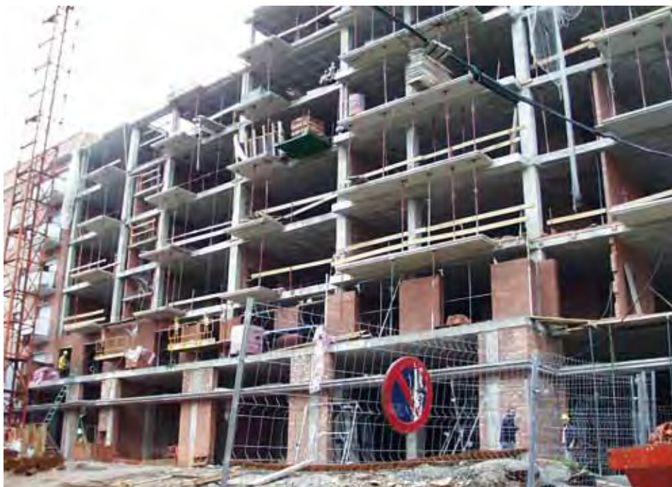
Edificis en construcció per als afectats del PERI del Fondo, any 2000. Fotografia de Sara Muñoz.
