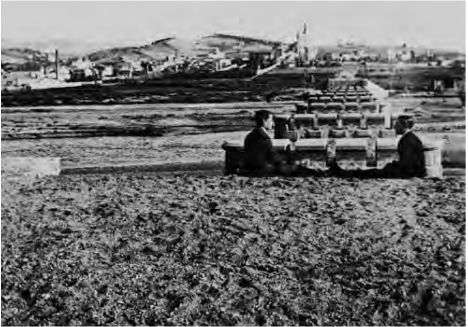
Construcció del primer pont sobre el Besòs.
