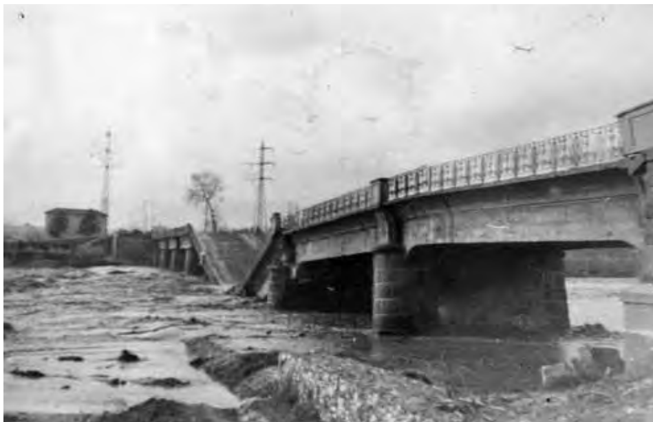
Imatge de l'estat en què va quedar el pont després de la riuada de 1943.
