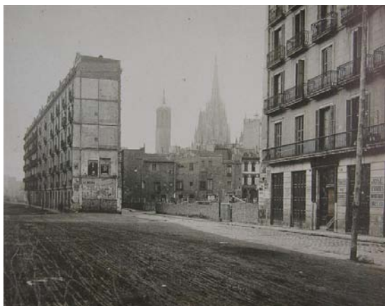
Obertura Via Laietana-avinguda de la Catedral
