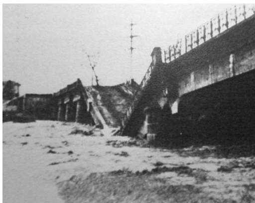
Ensorrament del pont el desembre de 1943
