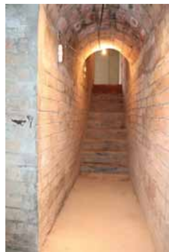
Escala d'accés al refugi des de l'exterior de l'edifici. (Museu Torre Balldovina).
