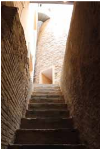
Escala d'accés al refugi des de l'interior de l'edifici. (Museu Torre Balldovina).
